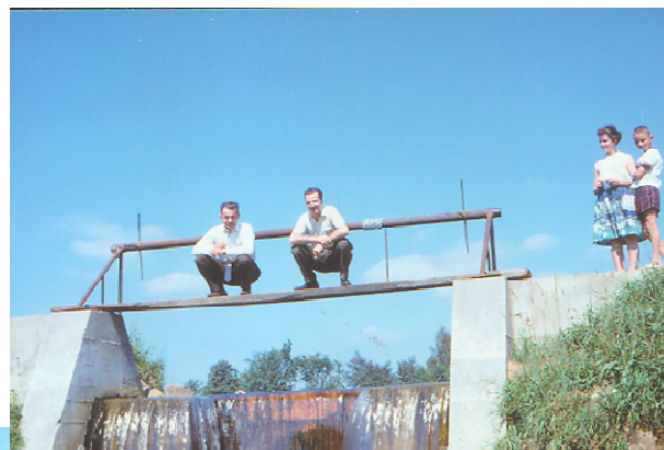
Le barrage du lac est encore visible aujourd'hui tout près de l'autoroute 40, du côté nord
