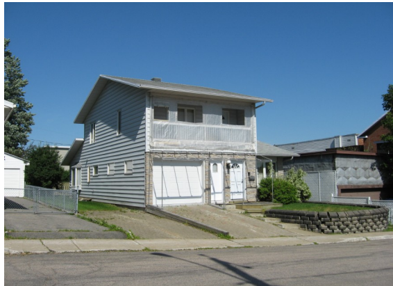
Maison de la rue Saint-Rédempteur à Beauport
